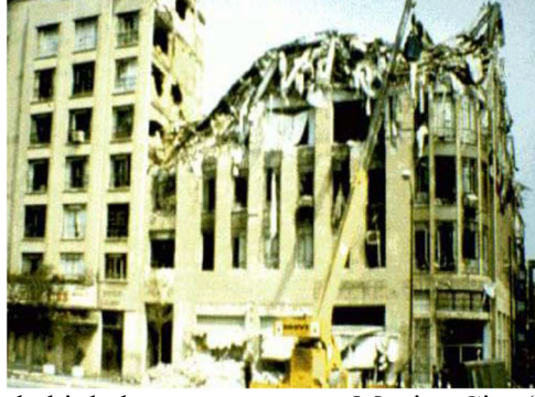
Şekil 1.4. Rezonans sebebiyle hasar gören yapı- Mexico City ( www.johnmartin.com )
