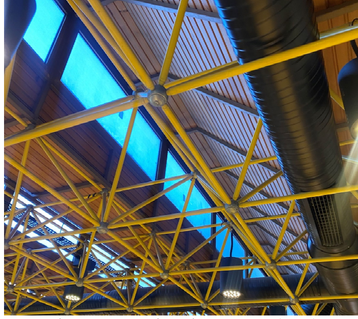
Resim 14: Şet çatı iç mekân ayrıntısı (2022)
