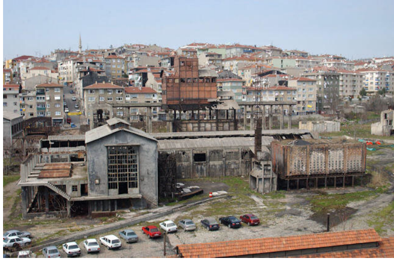
Şekil 9. Hasanpaşa Gazhanesi, Proje Öncesi Atıl Hali (2012)
